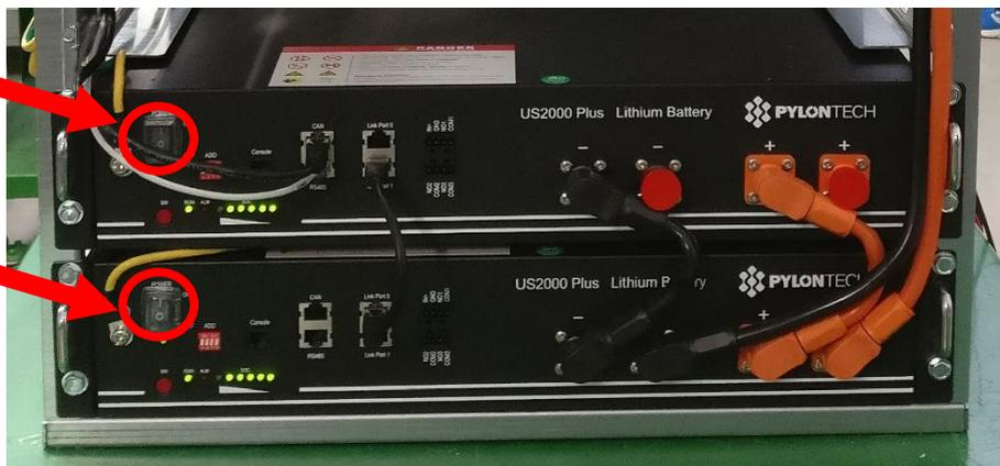
Figura 45 - Interruttori "0/1" moduli batteria: settare ad "1"
