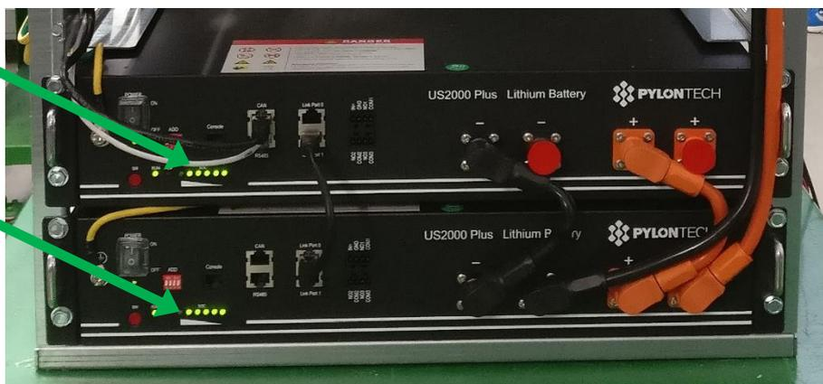
Figura 47 - Verificare accensione led moduli batteria
