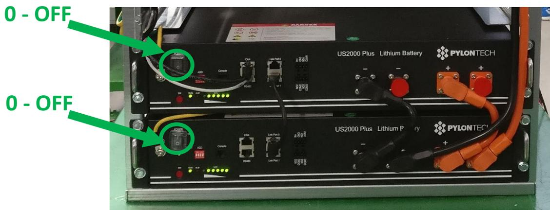
Figura 44 - Interruttori "0/1" moduli batteria: settare ad "1"
