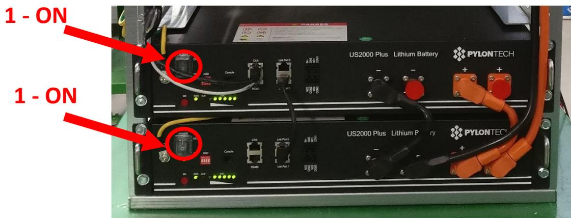
Figura 8 - Interruttori “0/1” moduli batteria: settare ad “1”
